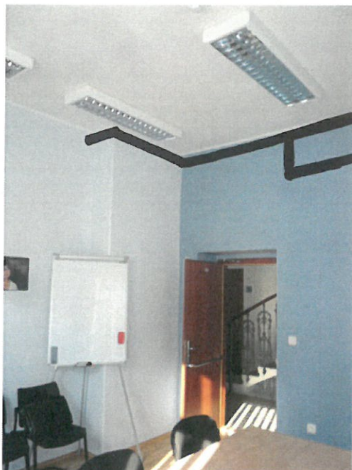
Místnost č. 104 - stávající stav / umístění vnitřní jednotky a trasa rozvodů v liště.
